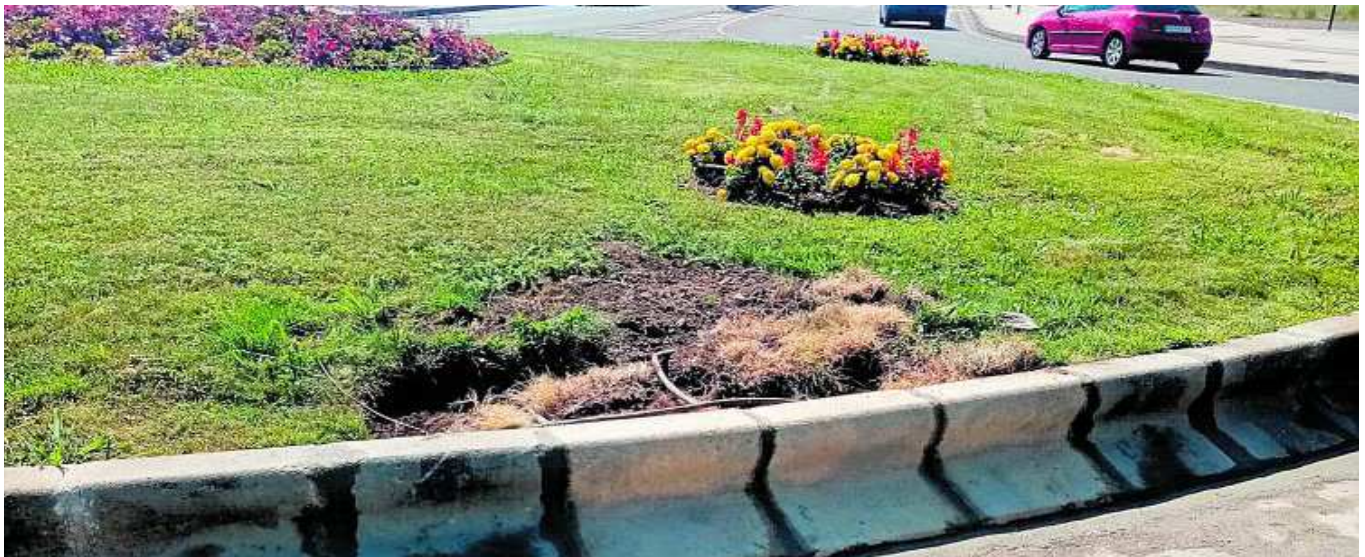
Reparación del bordillo de la glorieta de la Avenida de Asturias. :: L.N.C.
