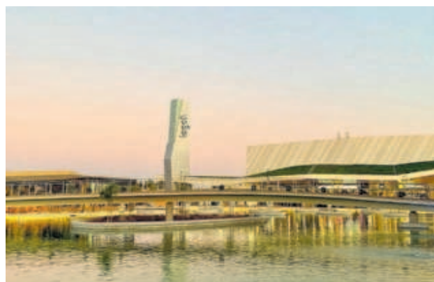
Centro comercial Lagoh en Sevilla.
