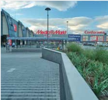
Rivas Futura: aceras y accesos peatonales.
