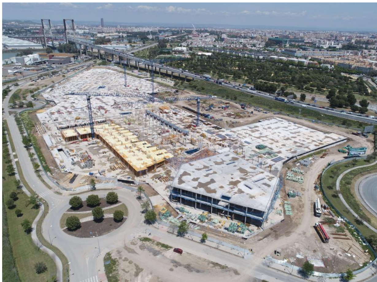
Vista general del avance de las obras de Palmas Altas
