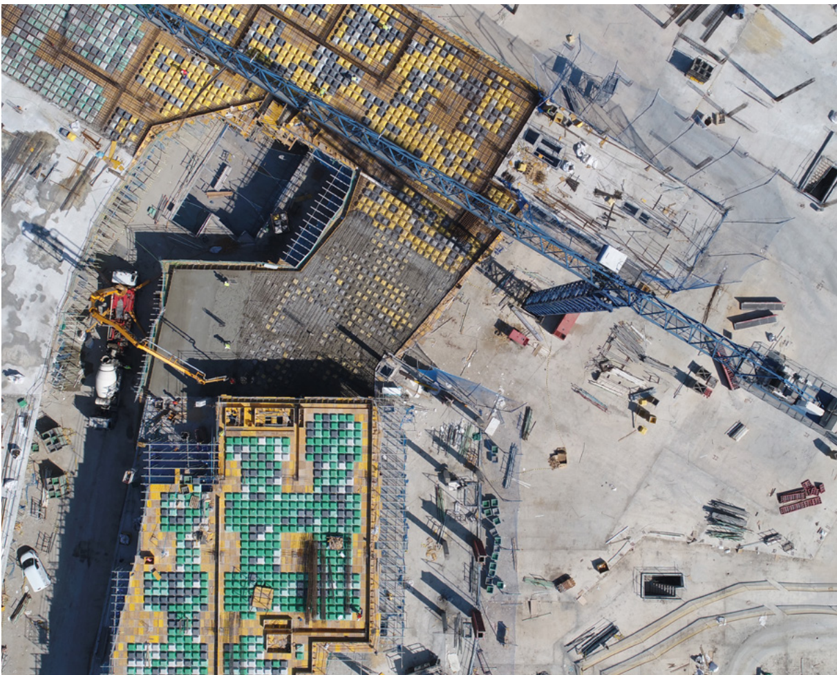
Avances de obra en Palmas Altas (Sevilla)
