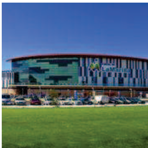
Fachada Exterior del Edificio
