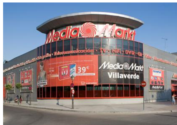
Fachada Principal del edificio Comercial
